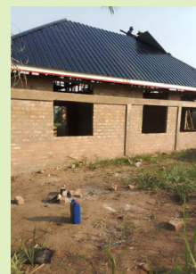
Fertigstellung des Rohbaus der Krankenstation
